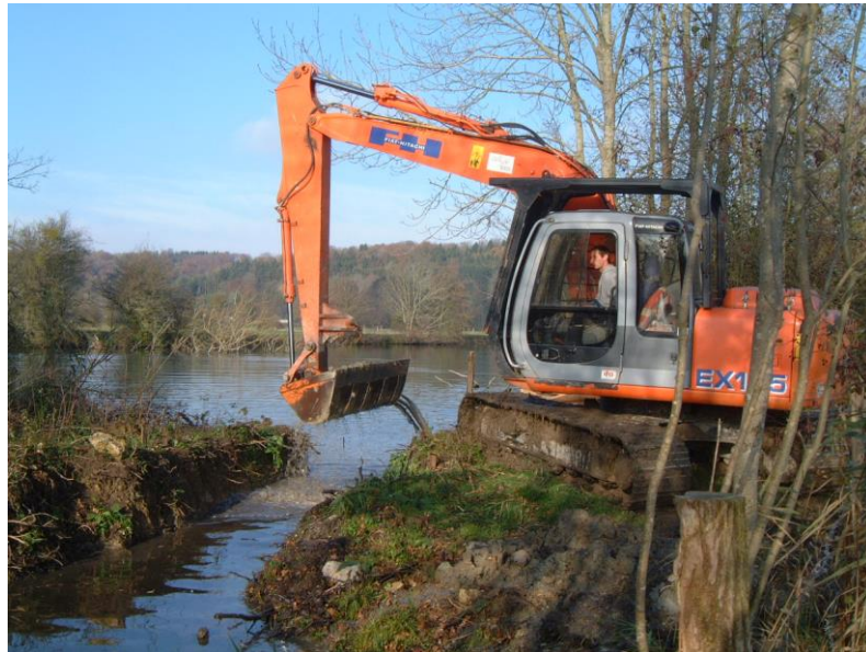
Création d'un chenal pour remettre en communication la noue de SIV 10 et la Meuse (2005)
