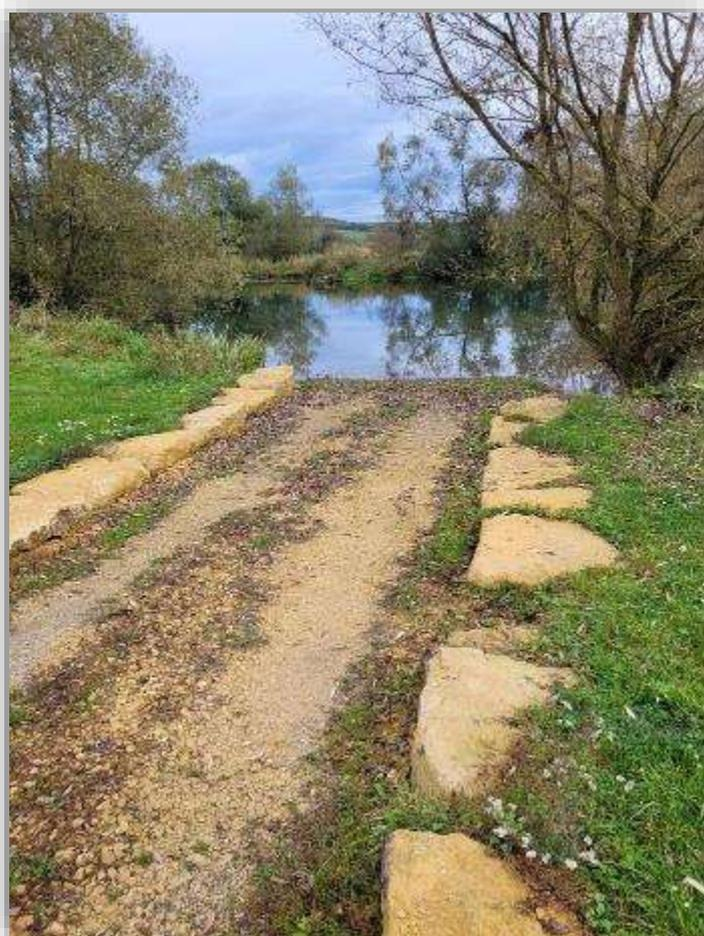
Figure 192 : Mise à l'eau moyennement fonctionnelle, par manque de pente, à Charny-sur-Meuse
