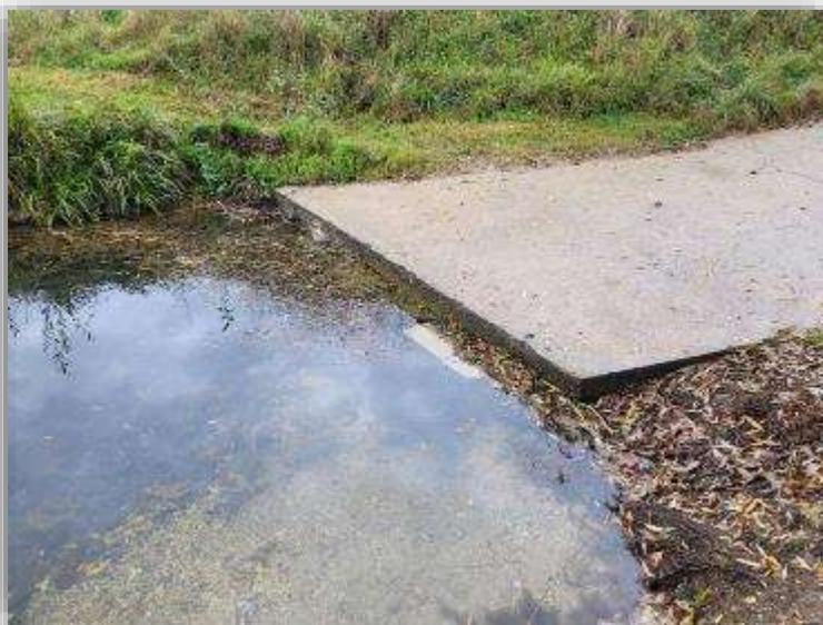
Figure 198 : Mise à l'eau du plan d'eau du Pré l'Evêque fonctionnelle ... sauf la marche en bout de rampe
