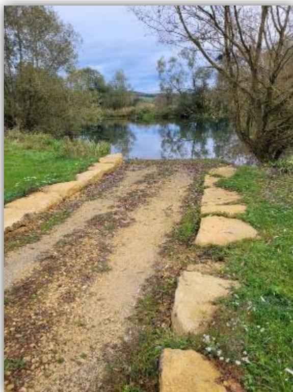
Figure 23 : La mise à l'eau de Charny-sur-Meuse manque de pente
