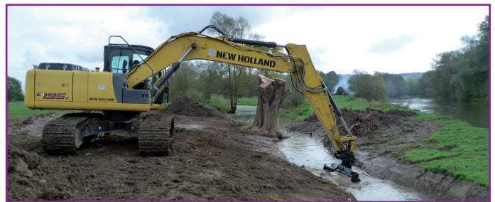
Travaux de restauration d'une annexe hydraulique à Maizey (2014)
