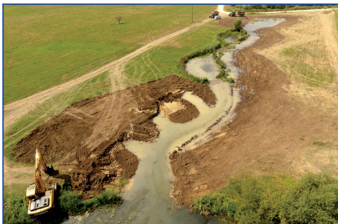
Photographie des travaux de restauration de l'annexe hydraulique
