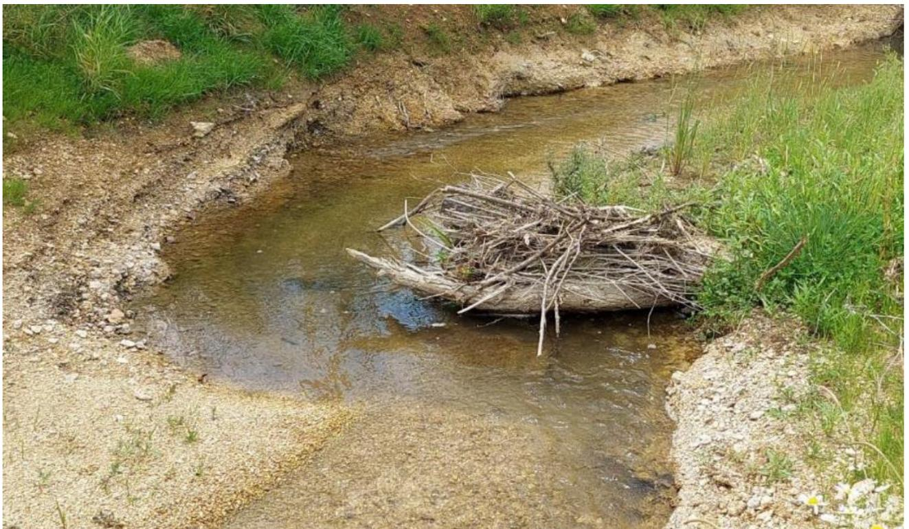
Figure 16 : exemple de cache piscicole implantées sous blocs (Source : ARTELIA 2022 – Ruisseau de l'Aulnois à Euville)
