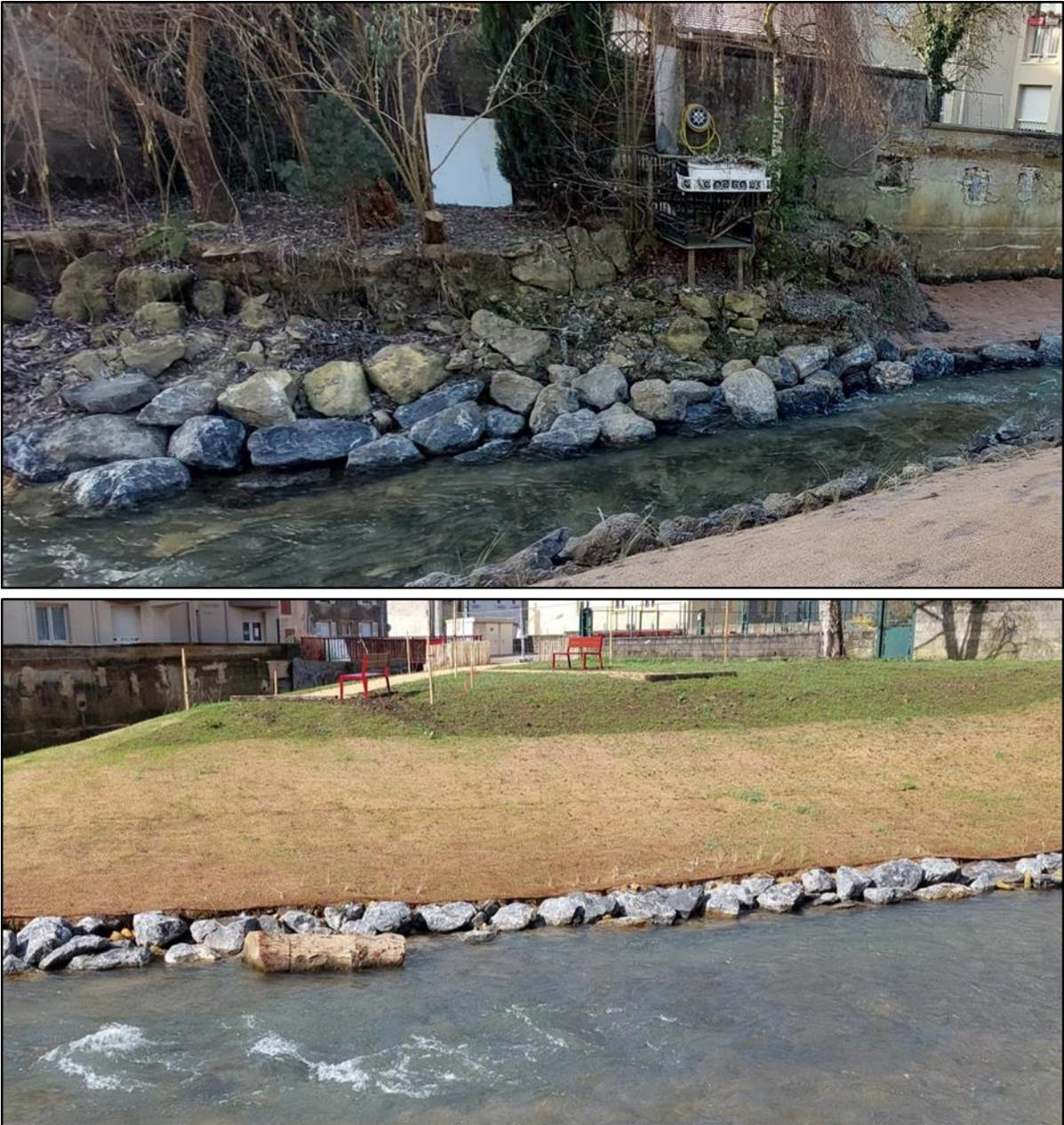
*Figure 18 : exemple de blocs en enrochements en pieds de banquettes générant des habitats piscicoles (Source : ARTELIA)*
