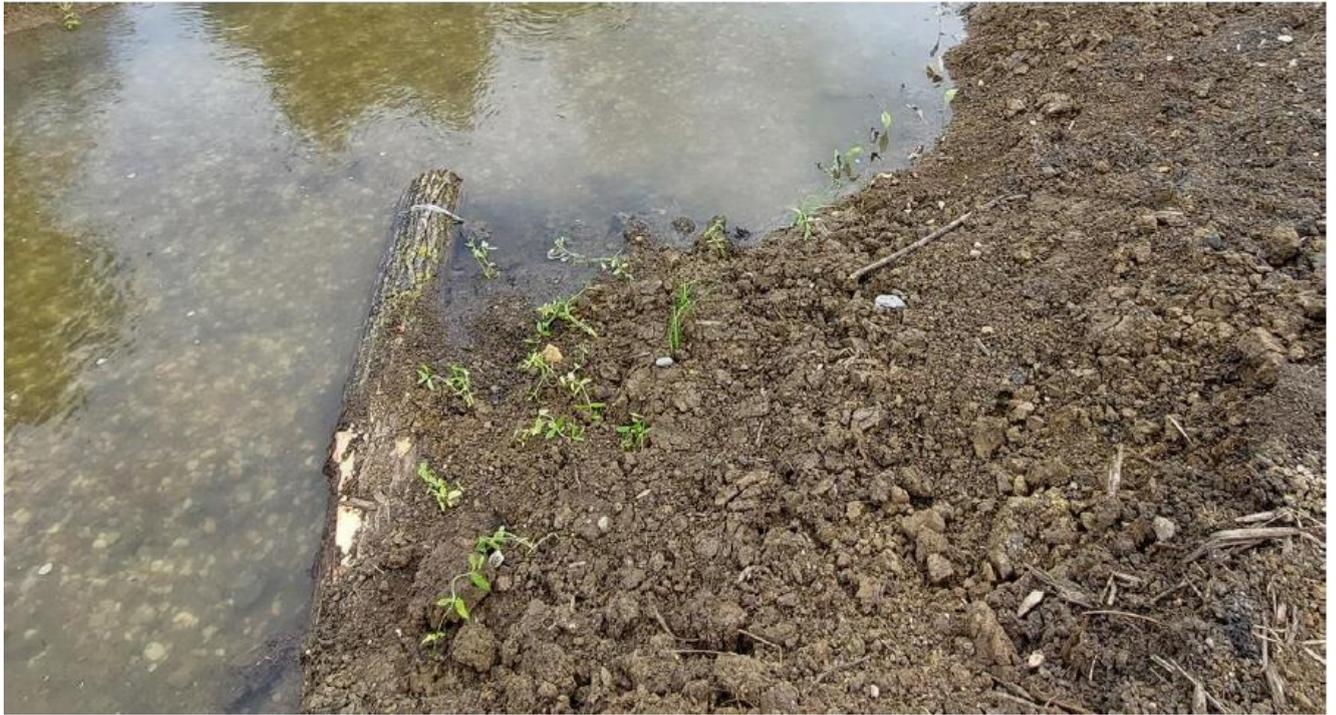
*Figure 20 : exemple de faux embâcle fixé sur une rive + plantation d'hélophytes (Source : ARTELIA 2023)*
