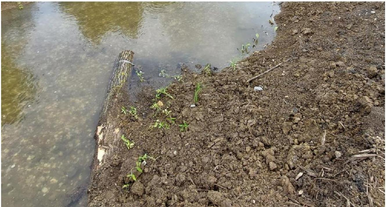
*Figure 11 : exemple de faux embâcle fixé sur une rive + plantation d'hélophytes (Source : ARTELIA 2023)*
